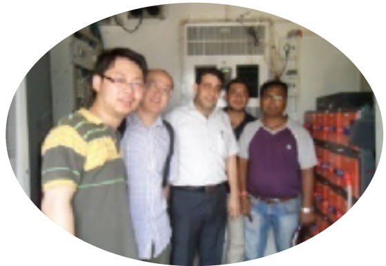
国外某机房高温电池应用
