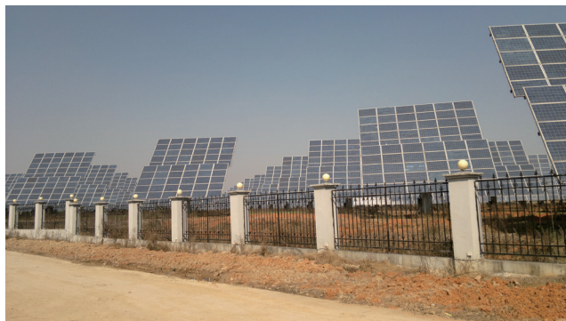
江西新余开发区示范项目
